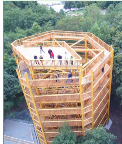
Barrierefrei erschlossener Aussichtsturm NATURPARK IRROTKÖ-GESCHRIEBENSTEIN
