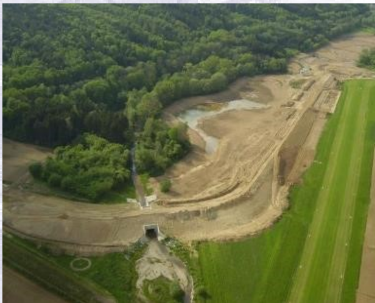
Pinkafeldi árcsúcs-csökkentő tározó építés közben (2014) – a modellben vizsgált egyik legnagyobb tározó, 494.000 m 3 kapacitással
