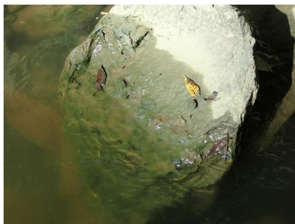
Abbildung 33: Blockwurf am Ufer der Raab bei St. Martin
