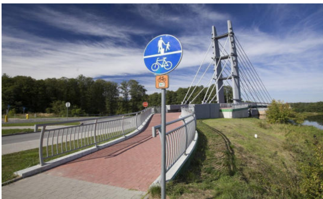
32. ábra: felújított híd különálló gyalog- és kerékpárúttal. Forrás: https://greenvelo.pl/
