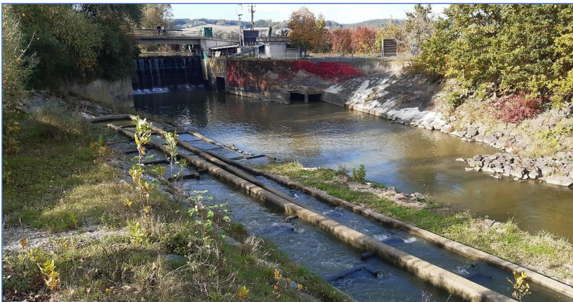
1. kép. A Rába (Raab) a Hohenbrugg an der Raab melletti duzzasztás alvizén (előtérben a hallépcső)
