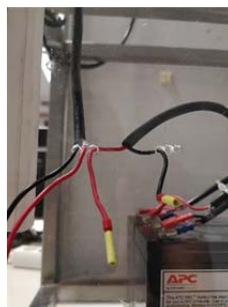
Kabel durch die Öffnungen ziehen (siehe Plan und Bild)
