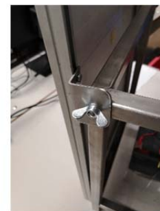
Solarpanel mit Hilfe der Winkel und der Gewindestange am Gestell befestigen
