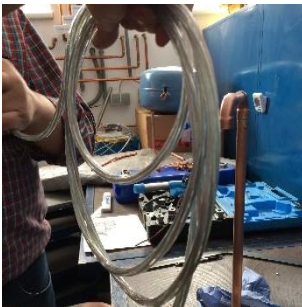
Kabel mit Hilfe der Feder durchziehen
