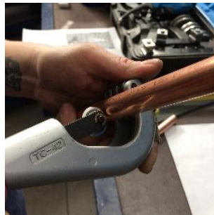
Rohre auf die gewünschte Länge abmessen, anzeichnen, abschneiden und entgraten
