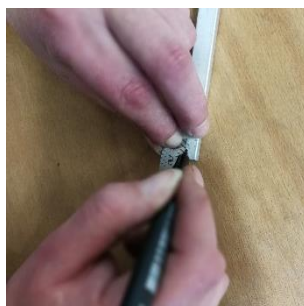
Bohrloch anzeichnen 5mm nach unten, Mitte
