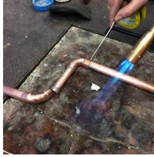
Alle Teile zusammenstecken und Verbindungsbereiche erhitzen und mit Lötendraht verlöten
