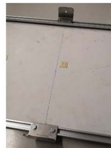
Winkel am Panel befestigen
